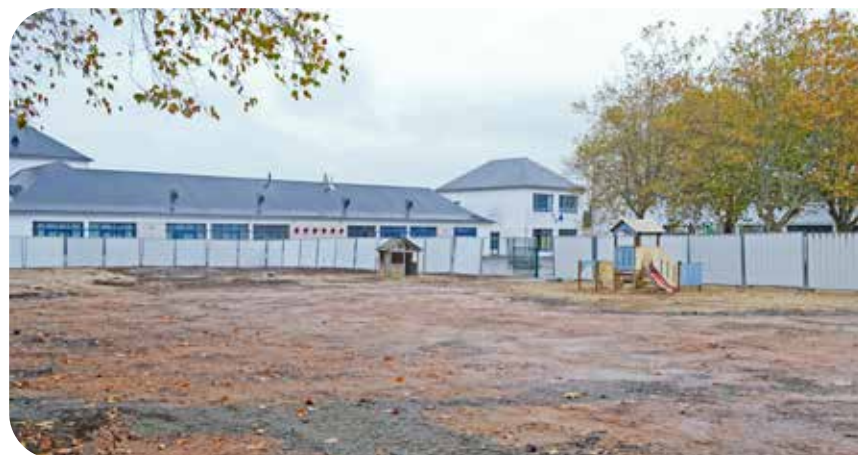
Les travaux ont commencé à l'école Bois Rochefort
