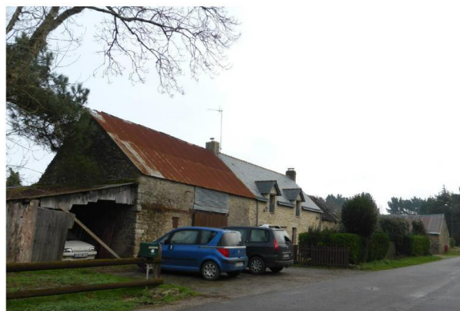
Bâti traditionnel avec disposition en L (Kerbironné)
