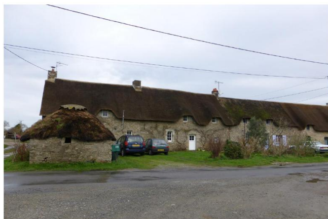
Bâti rural traditionnel à Bouzeray
