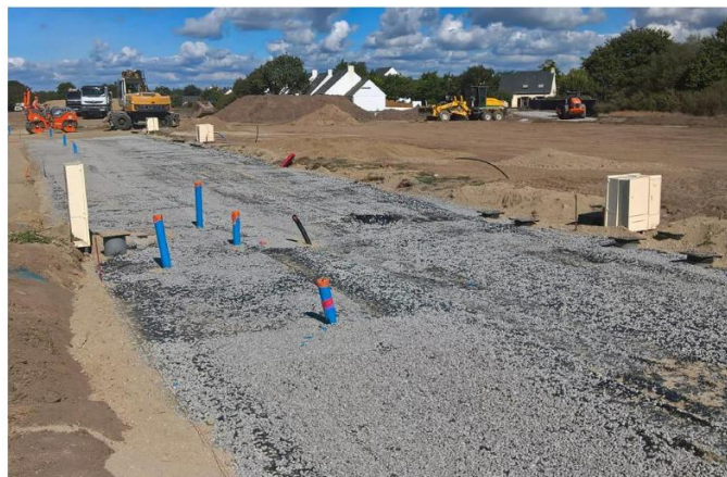
Les travaux de voirie en cours (2016-09)
