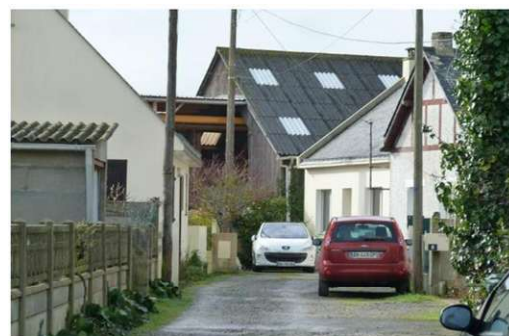
Le hangar du secteur 7 depuis l'impasse Aristide Briand
