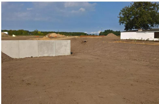
Les travaux de viabilisation en cours (2016-09)
