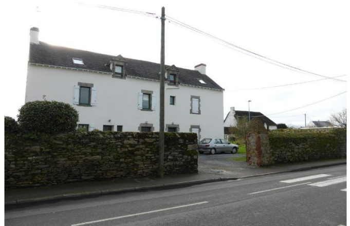
Grande maison de bourg en R+1+c marquant l'entrée nord
