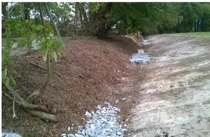
Elargissement et adoucissement d'une berge de fossé pour créer un ru, support de biodiversité
