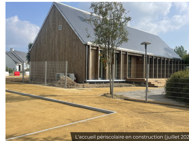
L'accueil périscolaire en construction (juillet 2025)
