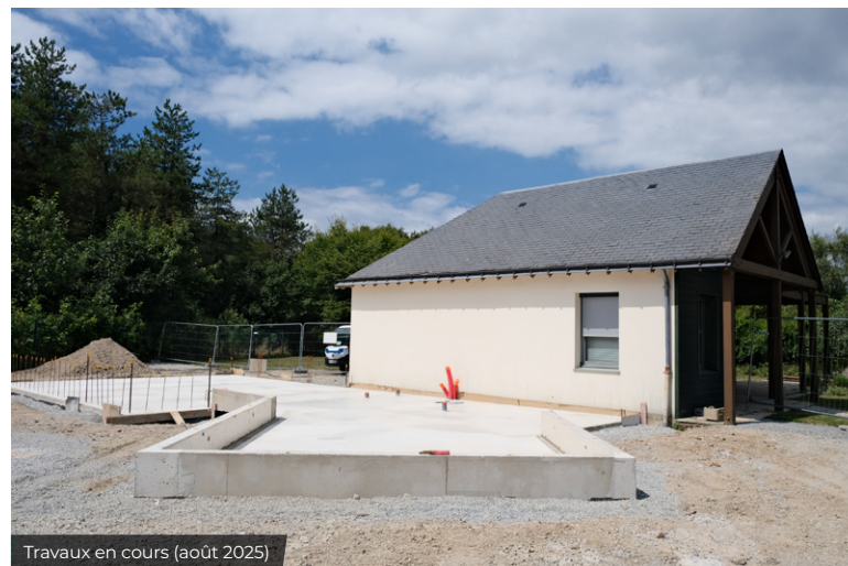
Travaux en cours (août 2025)
