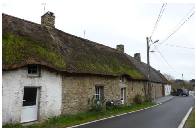
Bâti rural traditionnel à Gras
