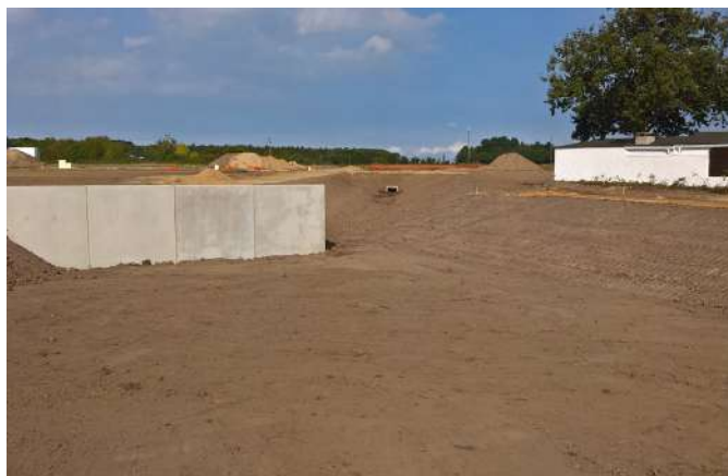
Les travaux de viabilisation en cours (2016-09)
