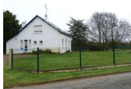
Une des habitations situées sur le bord de la Coulée Verte
