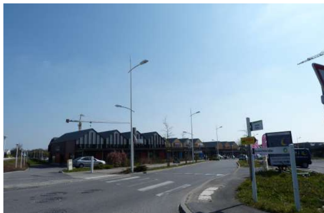
La future Avenue commerciale au niveau de la partie déjà réalisée rue de la Briquerie
