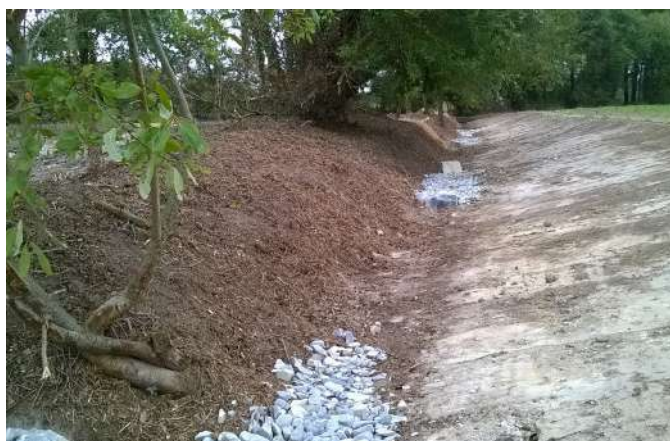
Elargissement et adoucissement d'une berge de fossé pour créer un ru, support de biodiversité
