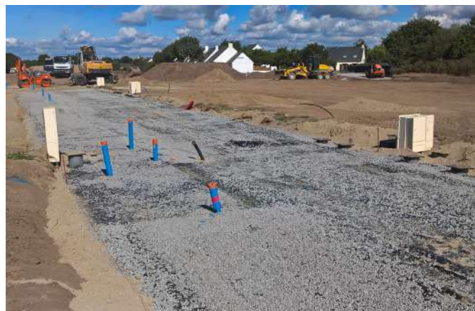
Les travaux de voirie en cours (2016-09)
