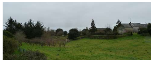
La ferme du Paradis et son socle minéral en transition avec le talweg
