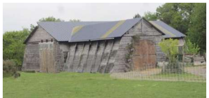
Bergerie à Asserac réinterprétant le type architectural de la salorge (source CA44)
