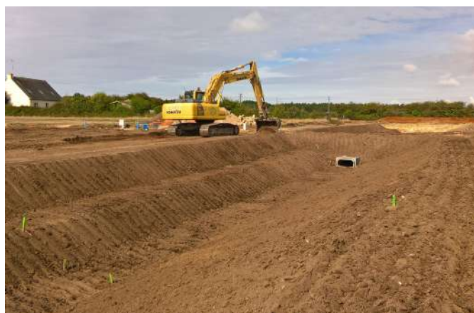
Le terrassement en cours des bassins de gestion des eaux pluviales (2016-09)
