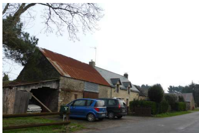
Bâti traditionnel avec disposition en L (Kerbironné)
