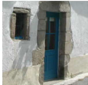
badigeon de chaux et encadrement pierres
