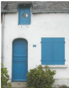
façade entièrement badigeonnée
