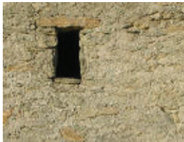
enduit à pierres vues
