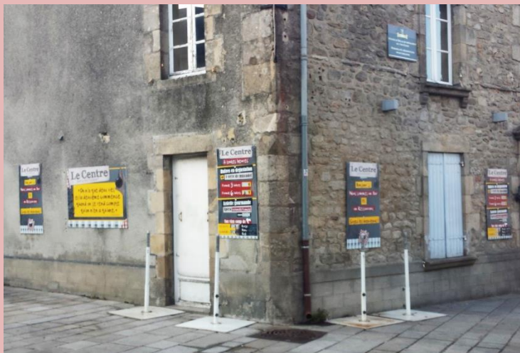
Enseignes peu valorisantes pour le bâti
